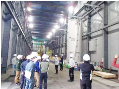
■ シールドトンネル工事現場を見学
