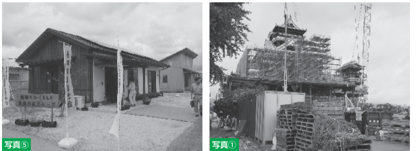
※熊本城の写真(①～③)は、視察・調査を目的に撮影された写真を掲載しました。(転載禁止)
